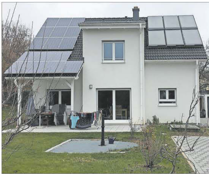
Das Haus der Familie Hartmann in Bad Säckingen hat dank Sonnenergie seine eigene Energieversorgung. FOTOS: SCHÄUBLE
