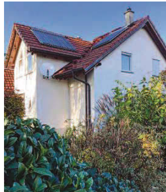
Das Haus von Michael Steinberner aus Erffingen-Kirchen ist energetisch für die Zukunft gerüstet.
