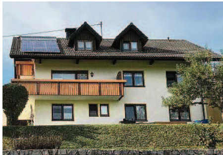
Pelletsheizung und Solar: Das Haus der Familie Ebner in Schönenbach am Schluchsee.
