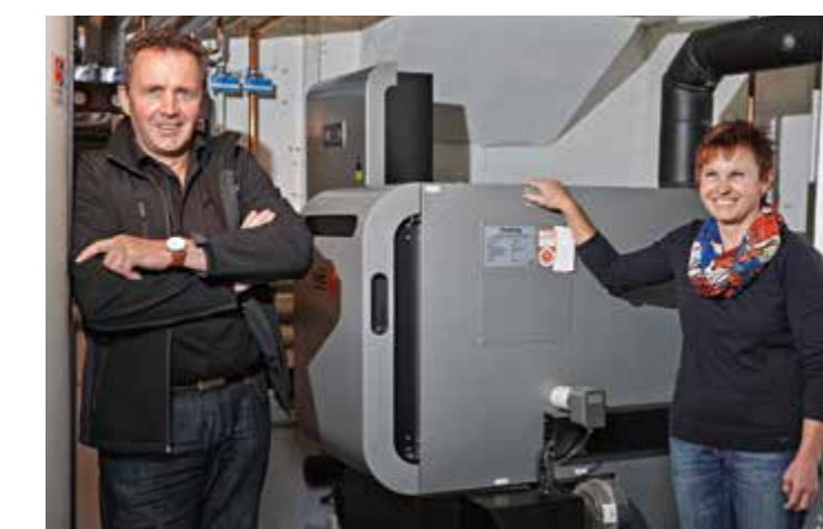
Der Kreis schließt sich: Bei Familie Vogt wird das Erstlingswerk von Manfred Schäuble durch eine moderne Hackschnitzelanlage ersetzt
